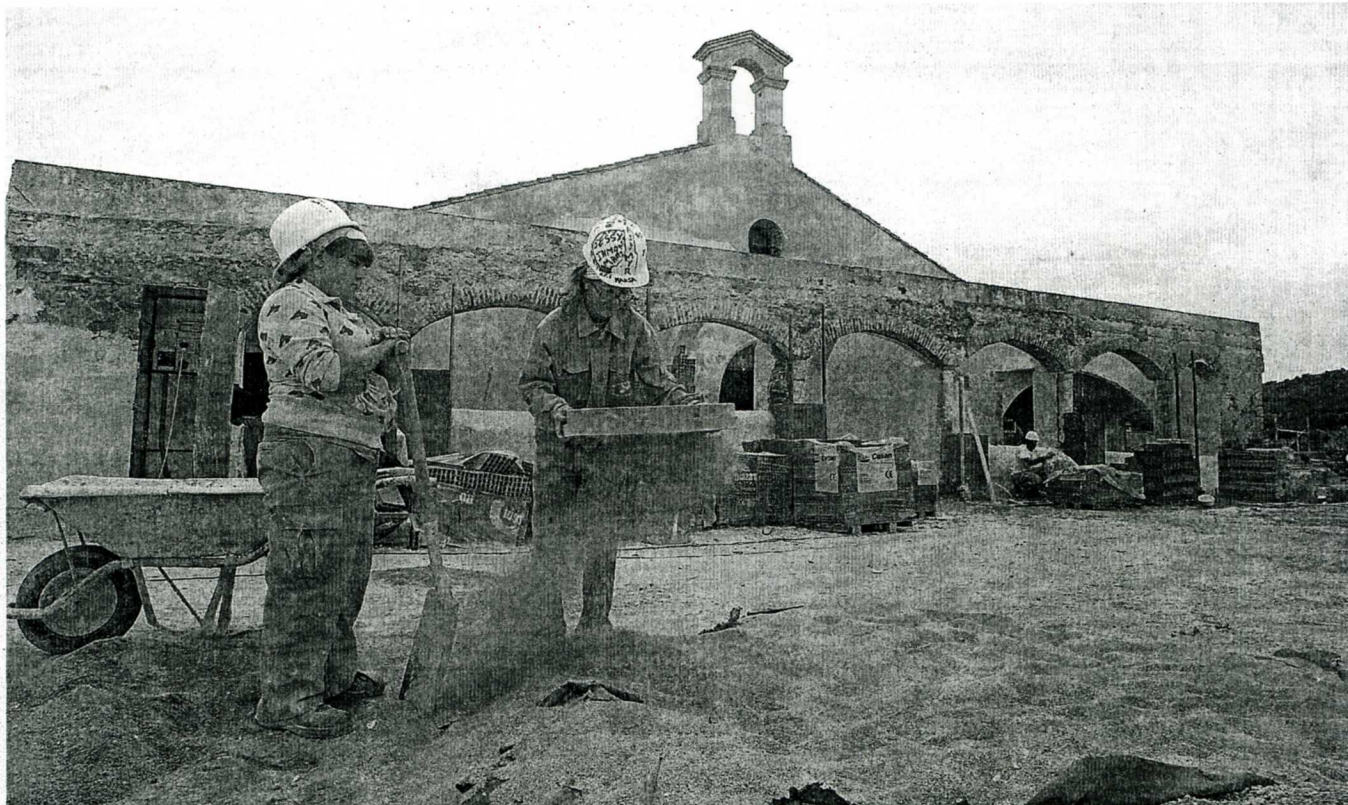
Dos alumnas de la escuela-taller San Benito II, de la Universidad Popular, trabajan en la rehabilitación del templo, situado en la urbanización Ceres Golf. / MARISA NÚÑEZ
