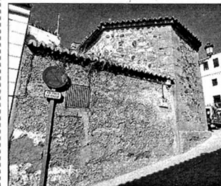
► Muro agregado que se eliminará.
