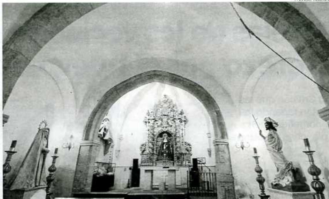
►► Interior de la ermita de la Soledad antes de que se iniciara la intervención.
